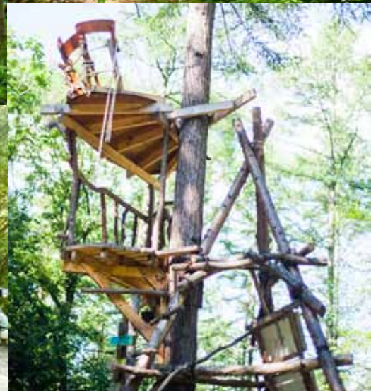
5: この森でもっとも多い1本樹六角形タイプのツリーハウス。カラマツ林の再生のために森に適したデザインから生まれ、雪や劣化、樹の生長などさまざまな条件に対応でき、軽くて造りやすい。室外は周囲できるベランダになっている 6: ソーラーパネルが設置された遊具で、センターエリアでは太陽光発電によって携帯電話の充電など最低限必要な電力は得ることができる 7: 宿泊ができるツリーハウスもある。室内は人の動きに合わせて揺れる構造で、すぐ近くには10m四方の大型のデッキがあり、イベントスペースとしても使われる 8: 六角形ではない2本樹型のツリーハウスは1本樹のものより安定性がある。全てのツリーハウスに使われているのは長野県産の間伐材で、南洋材や北米産のベニヤは使わない 9: センターエリア。大きな調理スペースがあり、ピザ釜や薫製釜も完備されている。ここでは会員制度が取られており、年会費はツリーハウスで2万円(ホストツリーの間借り代)、キャンプ8000円、1回限りのビジターは入郷料300円。ツリーハウスを見学する場合は2000円(要予約)となる 10: 各ツリーハウスには手製の階段があったり、ハンモックや遊具が吊るされていたりと、それぞれの持ち主によってさまざまな工夫が見られる。このツリーハウスでは量が敷かれていた
