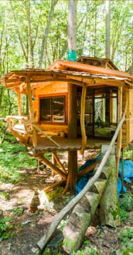
5: この森でもっとも多い1本樹六角形タイプのツリーハウス。カラマツ林の再生のために森に適したデザインから生まれ、雪や劣化、樹の生長などさまざまな条件に対応でき、軽くて造りやすい。室外は周囲できるベランダになっている 6: ソーラーパネルが設置された遊具で、センターエリアでは太陽光発電によって携帯電話の充電など最低限必要な電力は得ることができる 7: 宿泊ができるツリーハウスもある。室内は人の動きに合わせて揺れる構造で、すぐ近くには10m四方の大型のデッキがあり、イベントスペースとしても使われる 8: 六角形ではない2本樹型のツリーハウスは1本樹のものより安定性がある。全てのツリーハウスに使われているのは長野県産の間伐材で、南洋材や北米産のベニヤは使わない 9: センターエリア。大きな調理スペースがあり、ピザ釜や薫製釜も完備されている。ここでは会員制度が取られており、年会費はツリーハウスで2万円(ホストツリーの間借り代)、キャンプ8000円、1回限りのビジターは入郷料300円。ツリーハウスを見学する場合は2000円(要予約)となる 10: 各ツリーハウスには手製の階段があったり、ハンモックや遊具が吊るされていたりと、それぞれの持ち主によってさまざまな工夫が見られる。このツリーハウスでは量が敷かれていた
