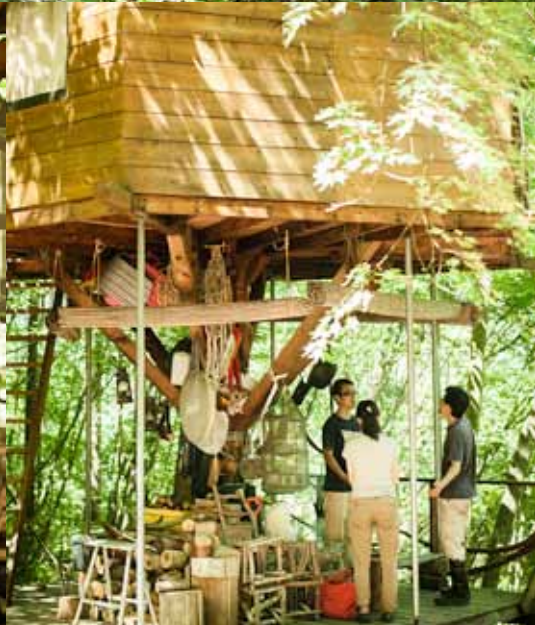
1: 300ha、東京ドーム約60個分という広大な森のなかにはいくつものツリーハウスが林立する。ここは6つのツリーハウスが並ぶ子どもの遊び場 2: 見学をさせてもらった静岡県富士市の家族のツリーハウス。築10年だが、大きな劣化は見られず、周囲もきちんと整備されている。ツリーハウスはホストツリーに大きな負担をかけるが、大切なのは周りの森をいかに手入れするかということ 3: ツリーハウスのコンセプトは、飾りや遊具ではなく、最低限の山暮らし。広すぎず便利すぎず、耐久性があって人の手で手入れが可能で、使わなくなったら自然に地に還ることが重要。固定はボルトではなく特殊なバンドで、樹の生長に合わせて5年に1度つけ直す 4: ツリーハウスの下は調理スペースとなっている。電気、ガス、水道はなく、近くの湧き水で水を汲み、枝を捨てて火をおこし、伐採した樹を薪にする。この森での大前提は「山火事を起こさないこと」で、基本的にルールはなく、自由に調理や遊びができる
